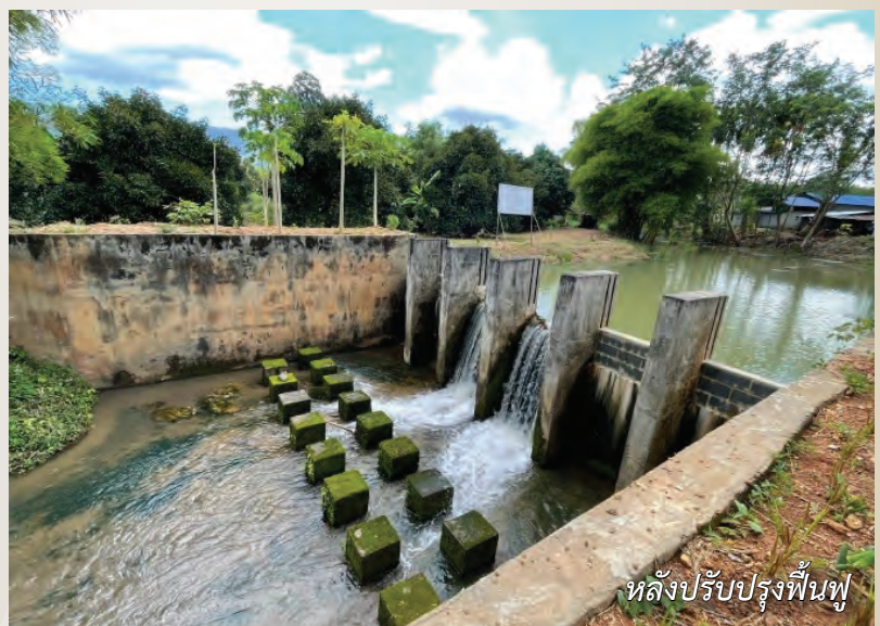
ภาพที่ ๕๔ ฝาย มข. ที่ได้รับการปรับปรุงให้ใช้งานได้เต็มศักยภาพในปัจจุบัน
