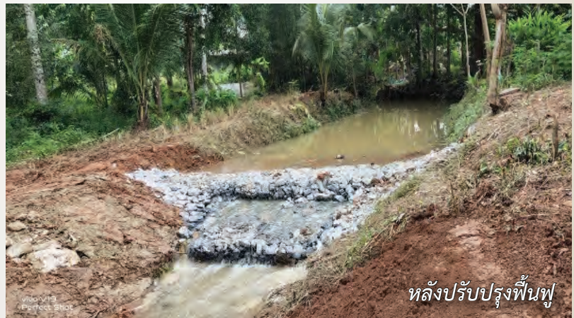
ภาพที่ ๕๓ ฝายชะลอน้ำ
