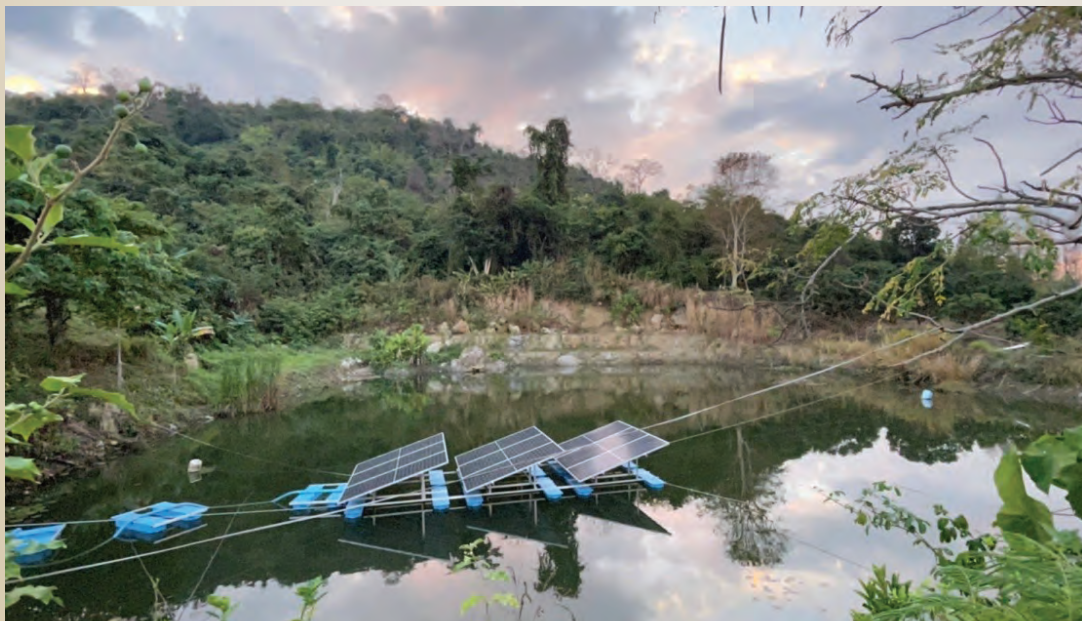
ภาพที่ ๖๖ พื้นที่เกษตรแปลงรวมและระบบสูบน้ำและกระจายน้ำในพื้นที่ด้วยพลังงานแสงอาทิตย์
