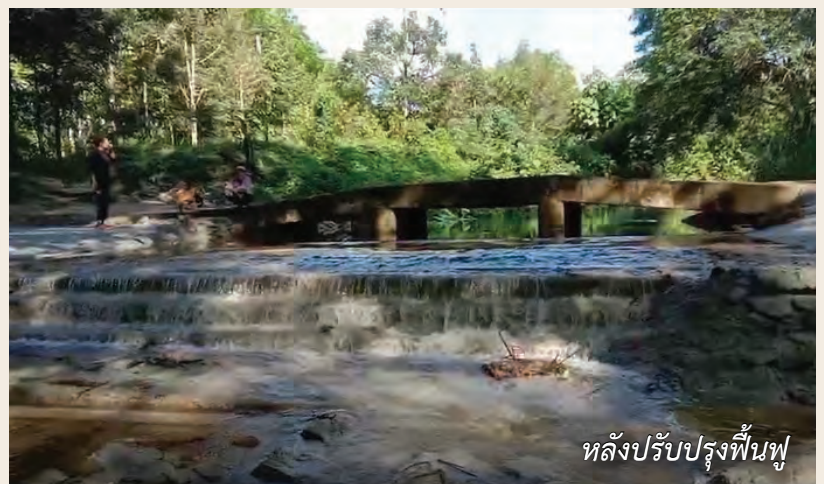
ภาพที่ ๕๘ ฝายชะลอน้ำด้วยเสาไฟฟ้า
