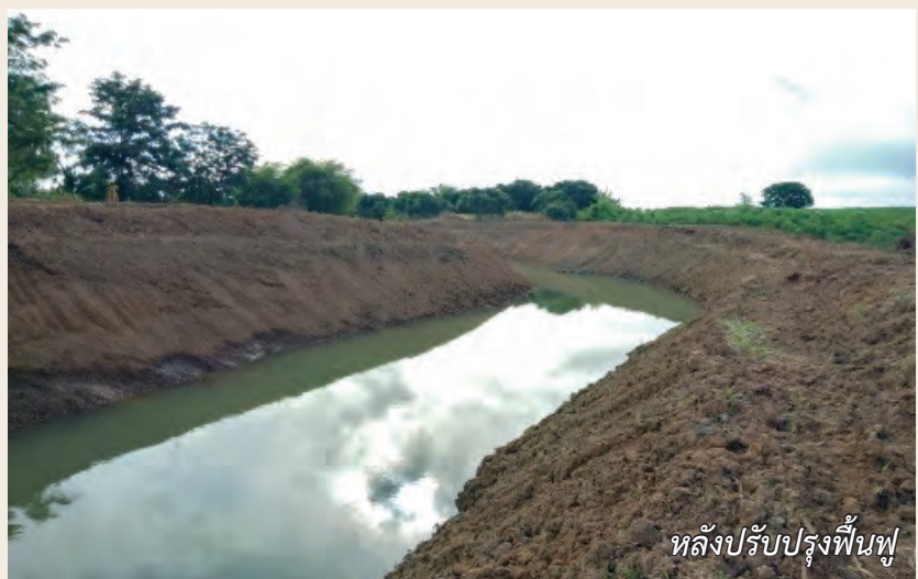
ภาพที่ ๖๘ งานขุดลอกคลองหนองเรือ ขยายความมั่นคงด้านน้ำเพื่อการเกษตร
